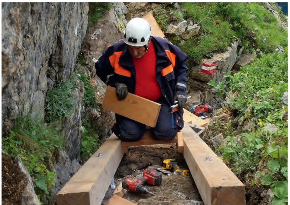
**Bild 11:** Hier werden die Trittstufen im Teilbereich U-5 eingebaut. Für jeden Teilbereich sind Treppensteigung und Auftritt neu zu ermitteln und einzuhalten. Josef hat auf diese Weise im Knien 101 Stufen montiert.
