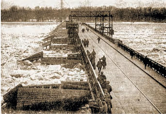
**Bild 34:** Etappenbrücke mit Eisbrecher
