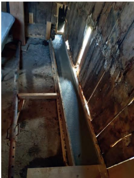
**Bild 1:** Mit dieser betonierten Mauerbank sind die Fundamentarbeiten im Saustallmagazin abgeschlossen.
