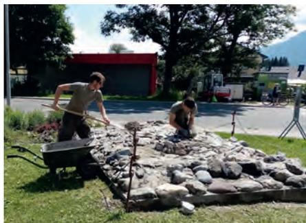
Am zweiten Tag standen Betonarbeiten an. Damit die Lafette eben steht, wurde für den Pivot Ring ein eigenes Podest betoniert.
