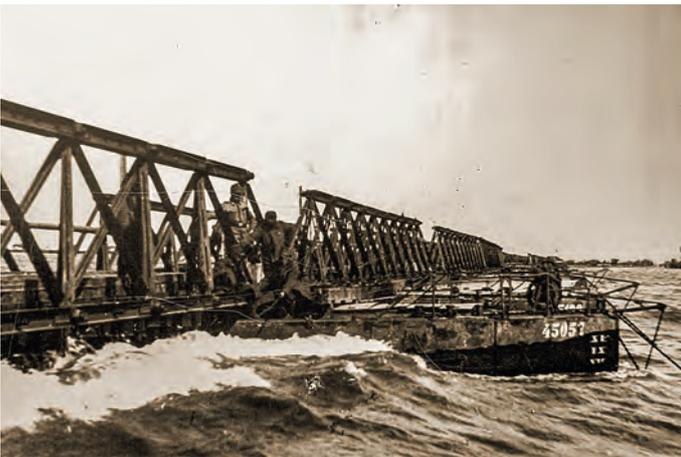
**Bild 30:** Eine auf Pontonen schwimmende Herbertbrücke bei Rustschuk
