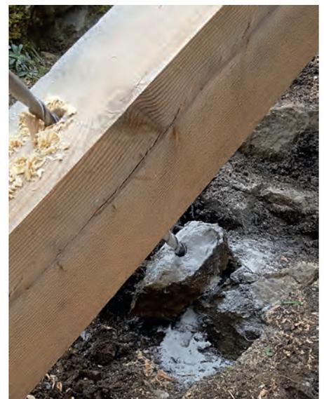
**Bild 10:** Nach dem Vorbohren des Holzes wird das Loch für die Verankerung des Gewindestabes im Fels gebohrt (Teilbereich U-5).
