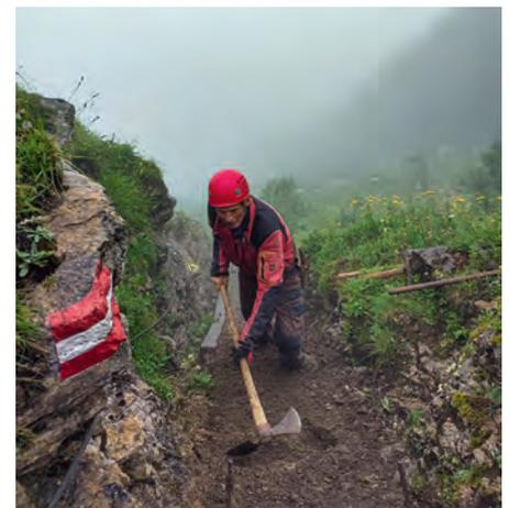
**Bild 5:** Erdreich und Schotter wurden – teilweise bei strömendem Regen – aus der Trasse entfernt (Teilbereich U-4).
