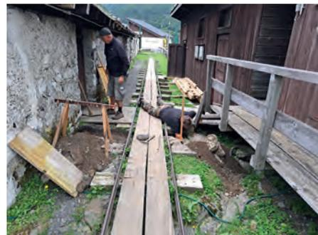
**Bild 4:** Klaus und Lutz beim Ausheben des Kabelschachts für die Drehstromleitung.
