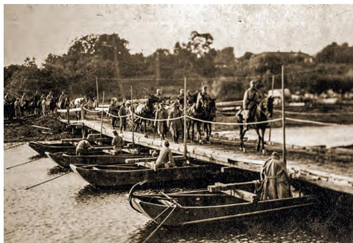
Bild 27: Birago-Brücke mit Brückenwache
