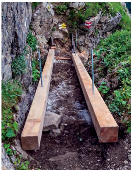
**Bild 9:** Die Holme sind eingepasst und die Orte festgelegt, wo die Gewindestangen im Fels verankert werden können (hier im Teilbereich U-5).
