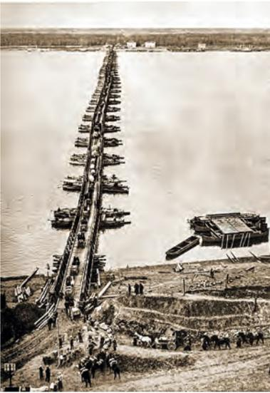
**Bild 29:** Eine auf Pontonen schwimmende Herbertbrücke bei Sistov (1916)
