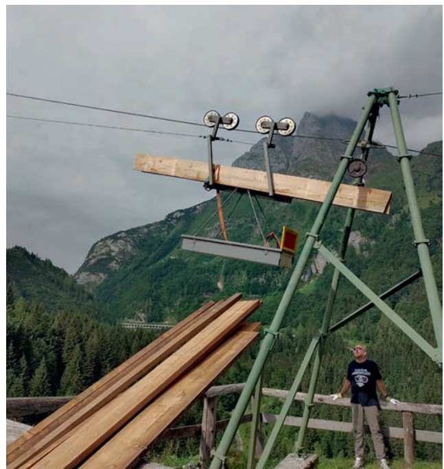
Bild 4: Beförderung von Langgut mit der Materialseilbahn.
