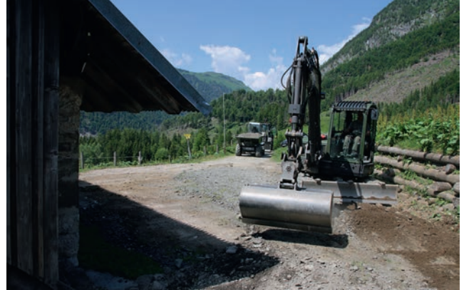
Bild 4: Der Bagger zog das Material am Parkplatz der Hausalm ab. Hangseitig wurde vor dem Verdichten des Materials noch zusätzlich eine Rinne für das Ableiten des Regenwassers gebaut.
