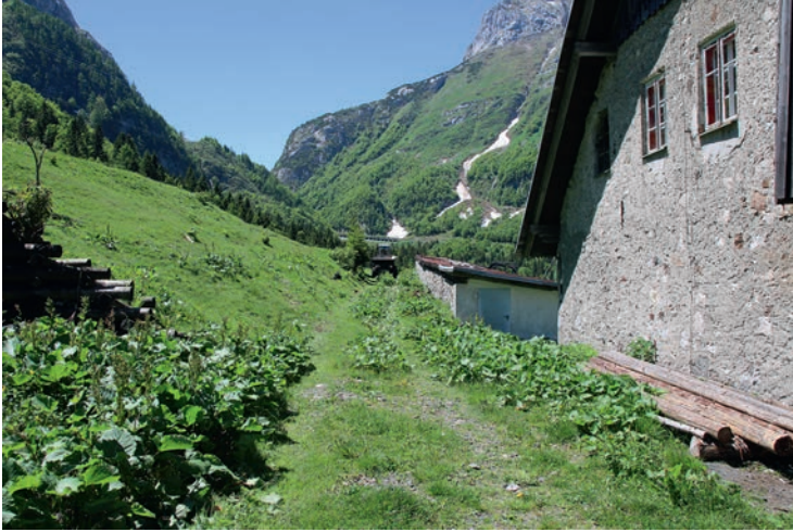
Bild 1: Die Arbeiten begannen am Zufahrtsweg südseitig der Hausalm in Richtung Materialeilbahn.
