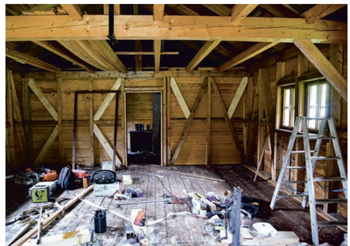
Bild 5: Zusätzliche Streben erhöhen die Stabilität der Konstruktion.
