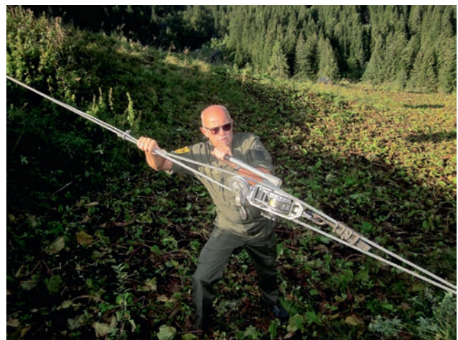
Bild 3: Vzlt Frankl beim Nachziehen eines Abspannseiles mit Hilfe des „Lug-All“ nach dem Setzen der neuen Klemmen.
