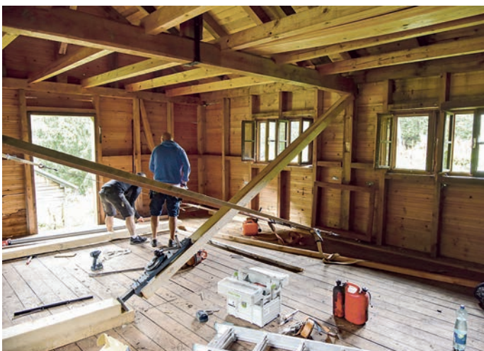
Bild 4: Beim behutsamen Richten der Konstruktion kamen Kurbelwinde, Seilzug und Spanngurte mit Ratsche zum Einsatz.
