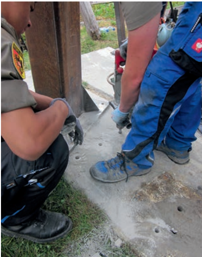
Bild 7: Sechs Hilti-Klebeanker mit einem Durchmesser von 20 mm und eine Länge von 24 cm wurden für den Steher gesetzt.
