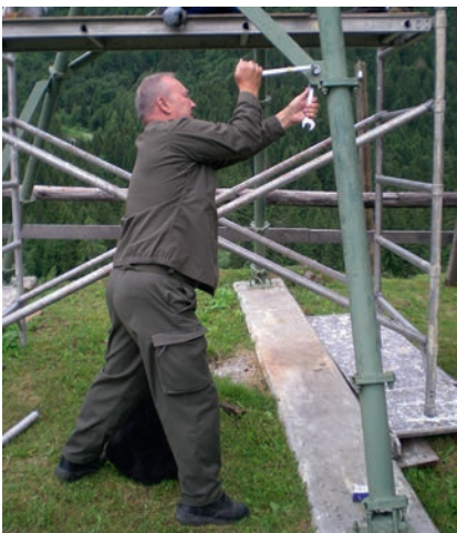
Bild 10: Vzlt Tasch beim Verschrauben der Querstrebe.
