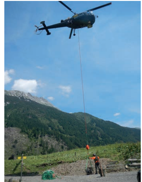
Bild 2: Die erste Außenlast für das Höhenlager am Kleinen Pal war ein 15-KW-Aggregat für den Seilaufzug vom Höhenlager zum Gipfelbereich am Kleinen Pal. Sämtliche Arbeitsgeräte und weitere Utensilien wurden im Netz verpackt und punktgenau neben der Hütte im Höhenlager abgesetzt.
