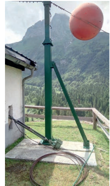
Bild 9: Ein Teil ist fertig!
