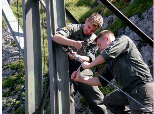
Bild 2: Insgesamt mussten 260 Stück Klemmen neu gesetzt werden.
