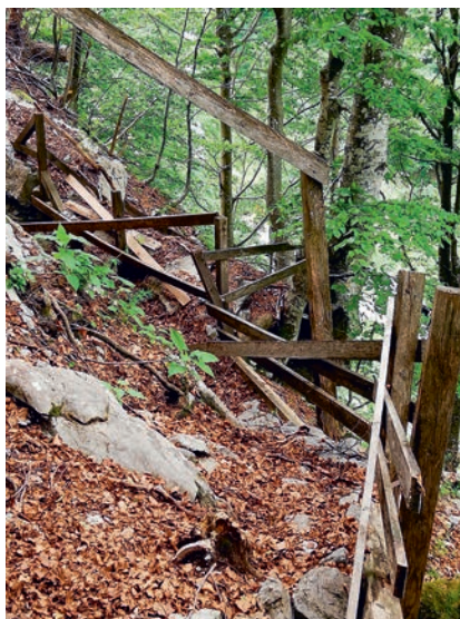
Bild 2: Viele Holzgeländer hatten den Schneedruck nicht standgehalten und mussten erneuert werden. Auch mussten sämtliche benötigten Baumaterialien und das Werkzeug von den Soldaten zu Fuß zu den einzelnen Baustellen getragen werden.
