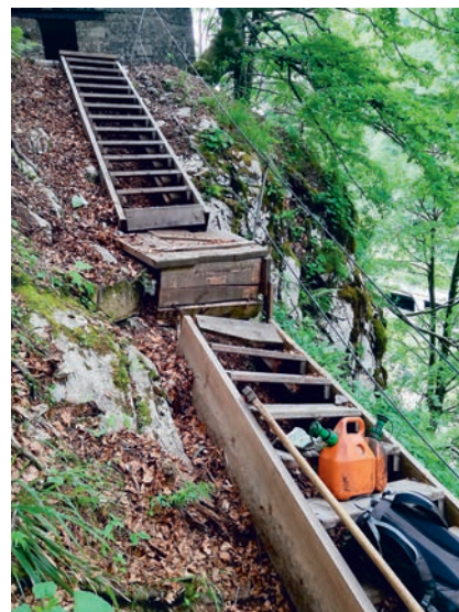
Bild 3: Im Jahr 2019 wurde von den Soldaten des JgB 26 die durch das Sturmtief "Vaja" zerstörte Treppenanlage gebaut. (Siehe DF II/2019)
