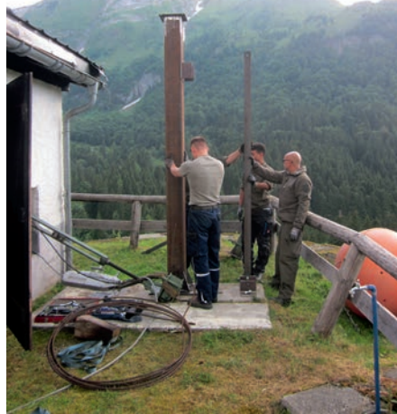
Bild 8: Ausrichten des neuen Mastes.
