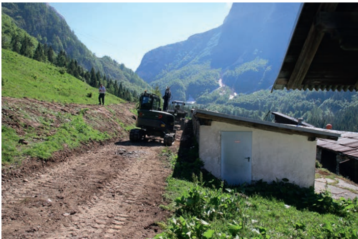
Bild 2: Zuerst wurde die gesamte Grasnabe abgenommen und der Weg verbreitert. Das gewonnene Material verbaute man im Hang und der Weg wurde geebnet.
