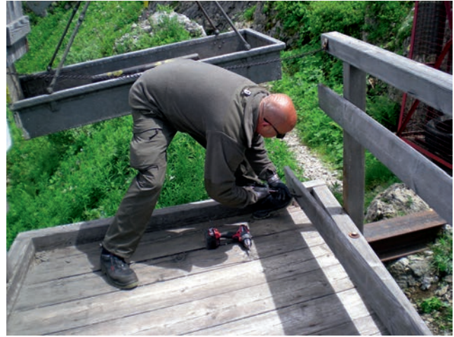
Bild 6: Vzlt Frankl nimmt kleinere Reparaturarbeiten an der Seilbahn-bühne vor.
