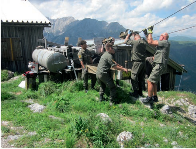
Bild 5: Das Einhängen des Seilbahnwagens des Seilaufzugs ist immer eine Schwerarbeit.
