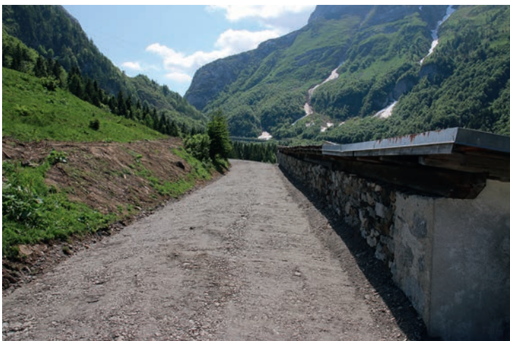
Bild 3: Nach dem Aufbringen des Schüttmaterials und dem Planieren kann sich die Zufahrt wieder sehen lassen.
