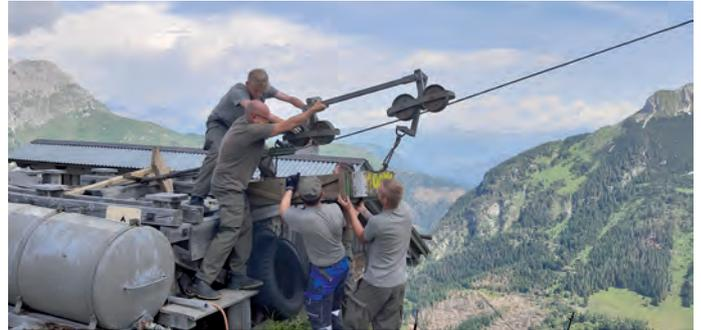
Bild 3: Um die Transportkiste des Seilaufzugs mit ihrem 4-rolligen Laufwerk auf das Tragseil zu setzen sind viele Hände und nahezu akrobatisches Geschick erforderlich.
