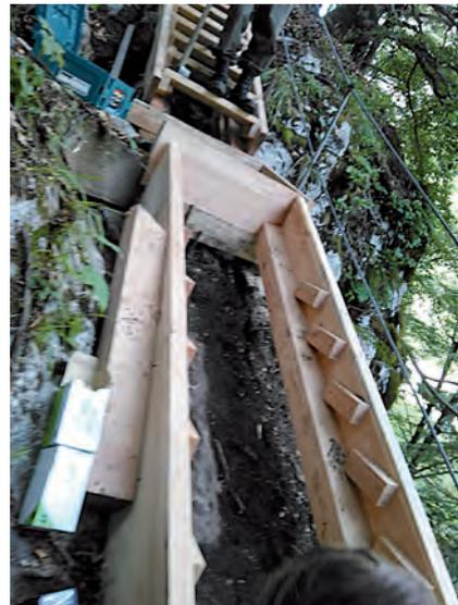
Bild 6: Gut ersichtlich: die Auflagehölzer für die Trittstufen.
