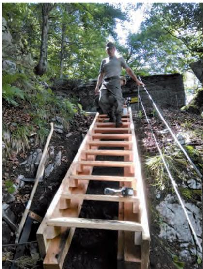
Bild 5: Der erste Teil der Treppe ist fertig. Als Handlauf und Sicherung dient ein Stahlseil.
