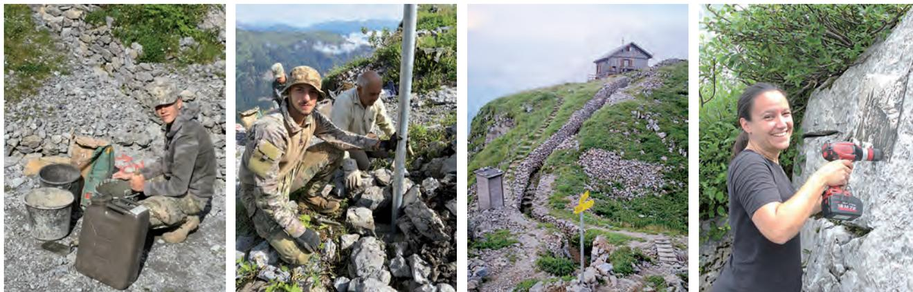
Bilder 26 bis 28: Das Einbetonieren der Wegpfosten bedeutete vor allem: Trockenbeton und Wasser schleppen. Bild 29: An geeigneten Stellen wurden historische Fotos montiert.
