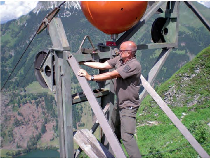
Bild 1: Entsichern des Spanngegengewichtes
