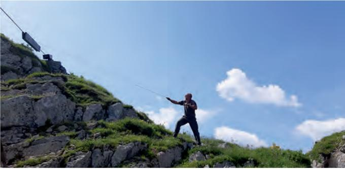
**Bild 5:** Das Ziehen des Zugseiles für den Seilaufzug ist mühsam. Hier muss von der Bergstation bis zum Höhenlager 120 m weit in teilweise schwierigem Felsgelände „querfeldein“ möglichst in der Linie des Tragseiles das Zugseil händisch gezogen werden.
