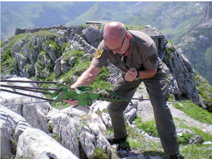
Bild 2: Auch am Tragseilanker wird jede Schraube gesichtet, geschmiert und festgezogen.
