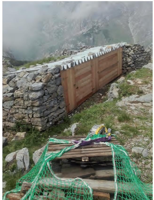
**Bild 3:** Nur die schöne Ansicht verrät den Neubau des Magazins, das in unveränderter Größe errichtet wurde. Im vorderen Bereich lagert das Abrissholz der alten Hütte zum Abtransport mit dem Hubschrauber.
