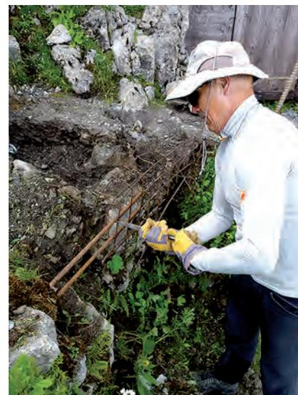
Bild 12: Heinz beim Absichern der Stelle mittels Eisendrahtgeflecht und Verankerung im Fels.
