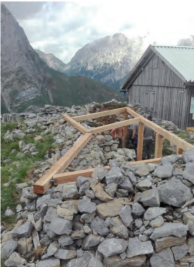
**Bild 2:** Die Unterkonstruktion des neuen Magazins konnten die Pioniere trotz des schlechten Wetters in eineinhalb Tagen fertigstellen.
