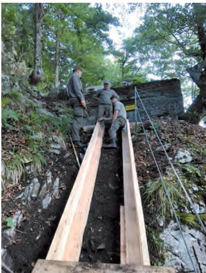
Bild 4: Nach dem Ausgleichen des Untergrundes wurden die Treppenwangen gesetzt.
